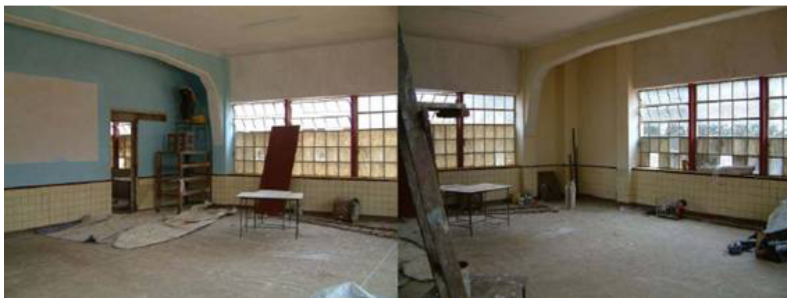
Laboratorio pre ristrutturazione
